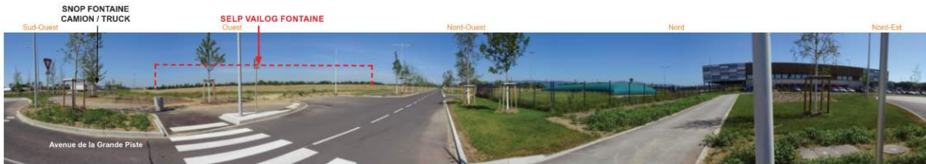
9 - VUE DEPUIS L'AVENUE DE LA GRANDE PISTE, VERS L'OUEST
